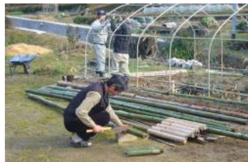
簡易小屋の内外にパイプに沿って竹 （地面に3cm程度埋め地上50cm 位の高さになるよう調節したもの） を設置し連結する。これで風対策と なる。
