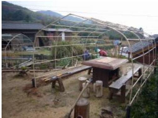
簡易な小屋の足を地面に埋め補強に 添え木をする
