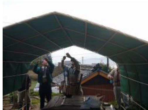
山の色に合わせて緑のテント地を被せ ひもで止めて、屋根にする
