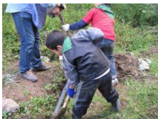
パイプを設置し埋め戻し作業中
